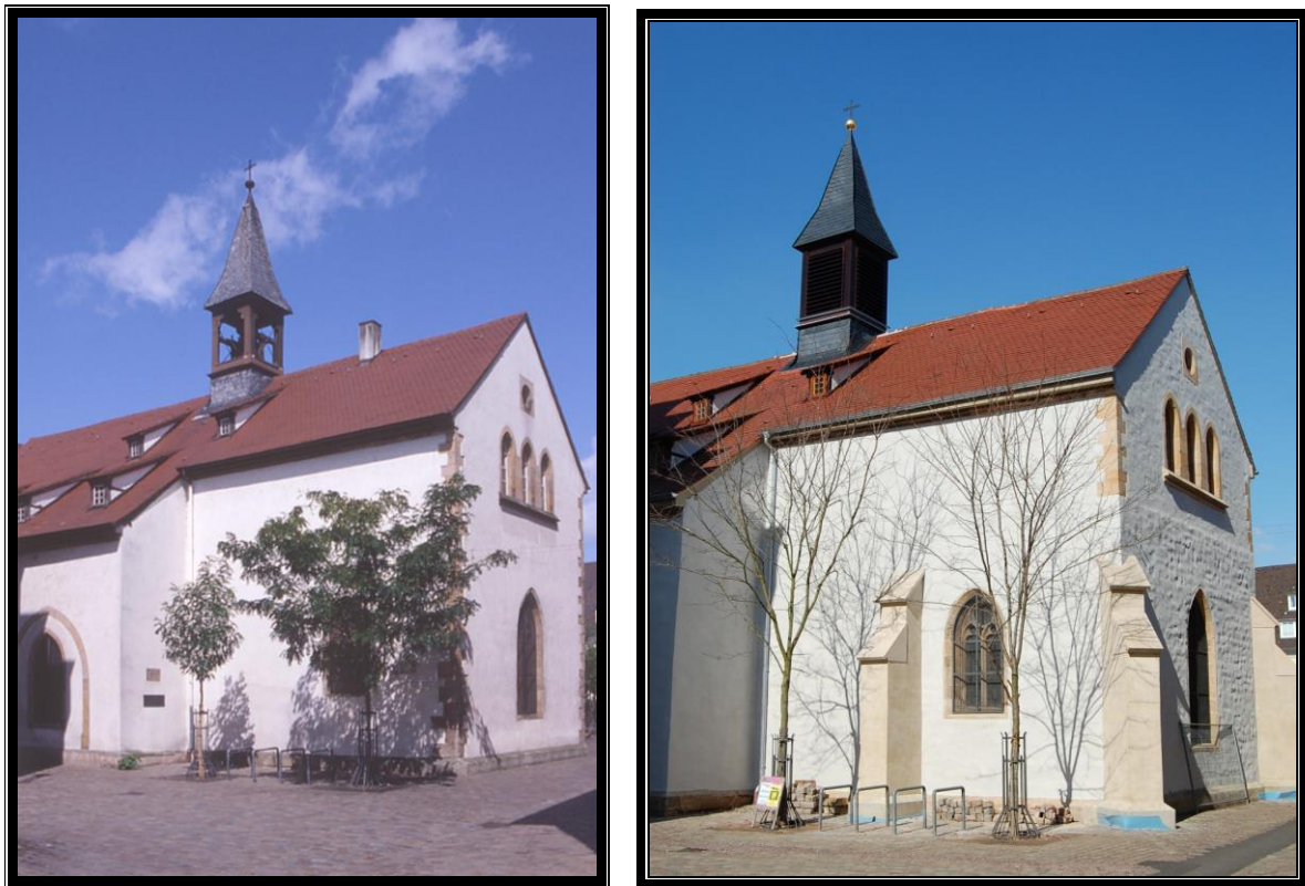
Bild 12: Links die Kapelle vor und rechts nach der Außensanierung mit den drei neuen Strebepfeilern, dem neuen Putz, der das alte Gemäuer betont, dem generalsanierten Dach mit neuem Dachreiter und vergoldetem Kreuz
